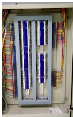
อุปกรณ์ควบคุมเครื่องปรับอากาศ และแสงสว่าง ทำหน้าที่คอยสั่ง ปิด - เปิด
