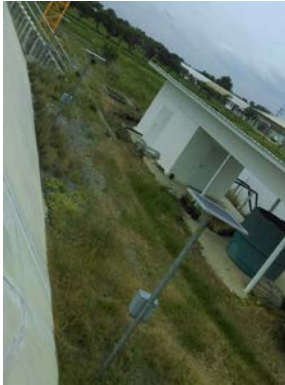
แผงโซลาร์เซลล์บริเวณรอบบ่อทดสอบความต้านทานพันธุ์ข้าวน้ำท่วม ของโรงสีข้าวรัฐโอสถ ขนาด 50 W จำนวน 16 แผง = 0.8
