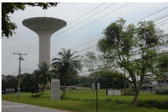
หอถังสูง ทำหน้าที่เก็บน้ำประปาเพื่อใช้ในการอุปโภคและผลิตน้ำดื่ม เพิ่มแรงดันในเส้นท่อ เพื่อส่งจ่ายน้ำประปาใช้ ภายในวิทยาเขตกำแพงแสน ภายในพื้นที่ 7,951.75 ไร่ และแบ่งจำหน่ายให้กับหน่วยงานภายนอก รวมทั้งชุมชนบริเวณโดยรอบ วิทยาเขตกำแพงแสน ความสูงเหนือระดับ น้ำทะเล 59 ม.
