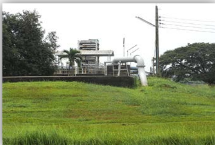
ถังเก็บน้ำใส โรงกรองน้ำหลังที่ 1 ทำหน้าที่เก็บกักน้ำใส (น้ำประปา) จากโรงกรองน้ำ 1,2 โดย มีท่อส่งน้ำใสจากโรงกรองหลังที่ 2 ขนาด 12 และมีหอเติมอากาศ
