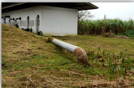
ท่อส่งน้ำใสจากโรงกรองน้ำหลังที่ 2 ส่งไปโรงกรองน้ำหลังที่ 1 ตามแนวท่อไยหิน 16 นิ้ว ซึ่งมีระยะทางประมาณ 3500 เมตร
