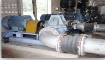
เครื่องสูบล้างหน้าทราย และเครื่องสูบน้ำล้างตะกอน อย่างละ 2 ตัว
